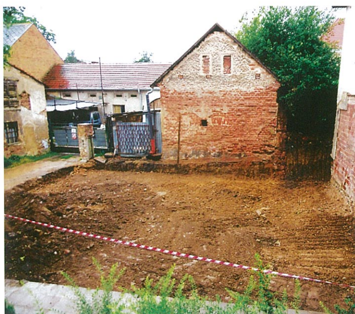
Demolice objektu na dvoře ÚMČ
