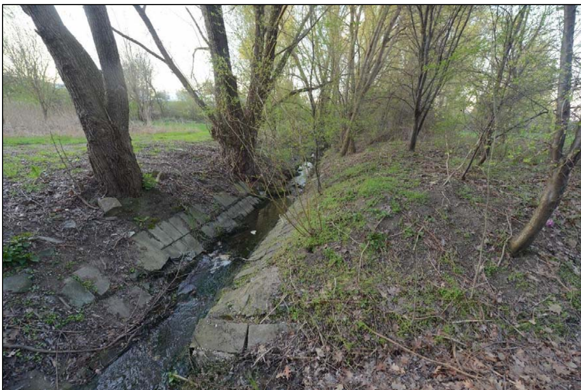
Obr. č. 18: Odvodňovací strouha s potenciálně cennými dřevinami v souvislém porostu na konci úseku C ve směru na Plzeň
