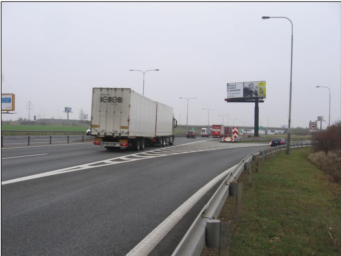
DB2: pohled na Úsek 1 proti směru staničení. V pozadí MÚK Slivenec.
