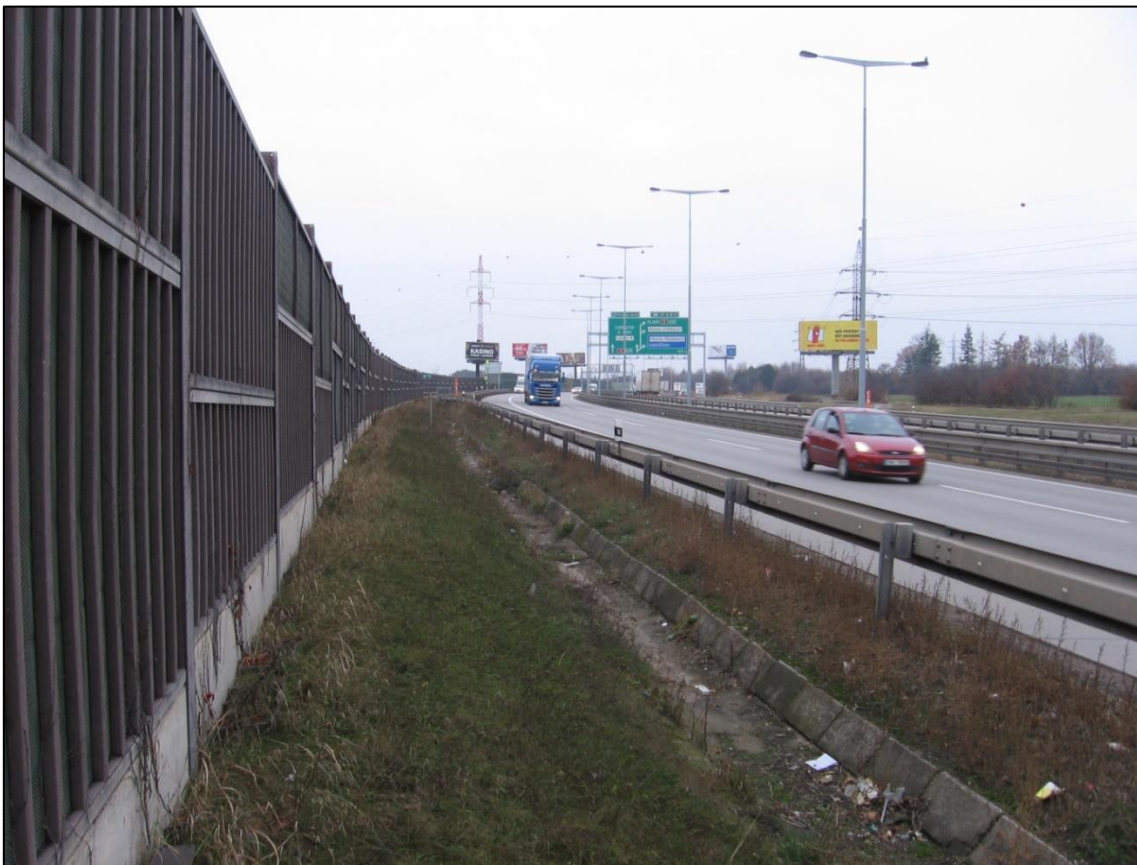
DB 13: pohled na Úsek 3 ve směru staničení, trasa přechází do pravého oblouku.
