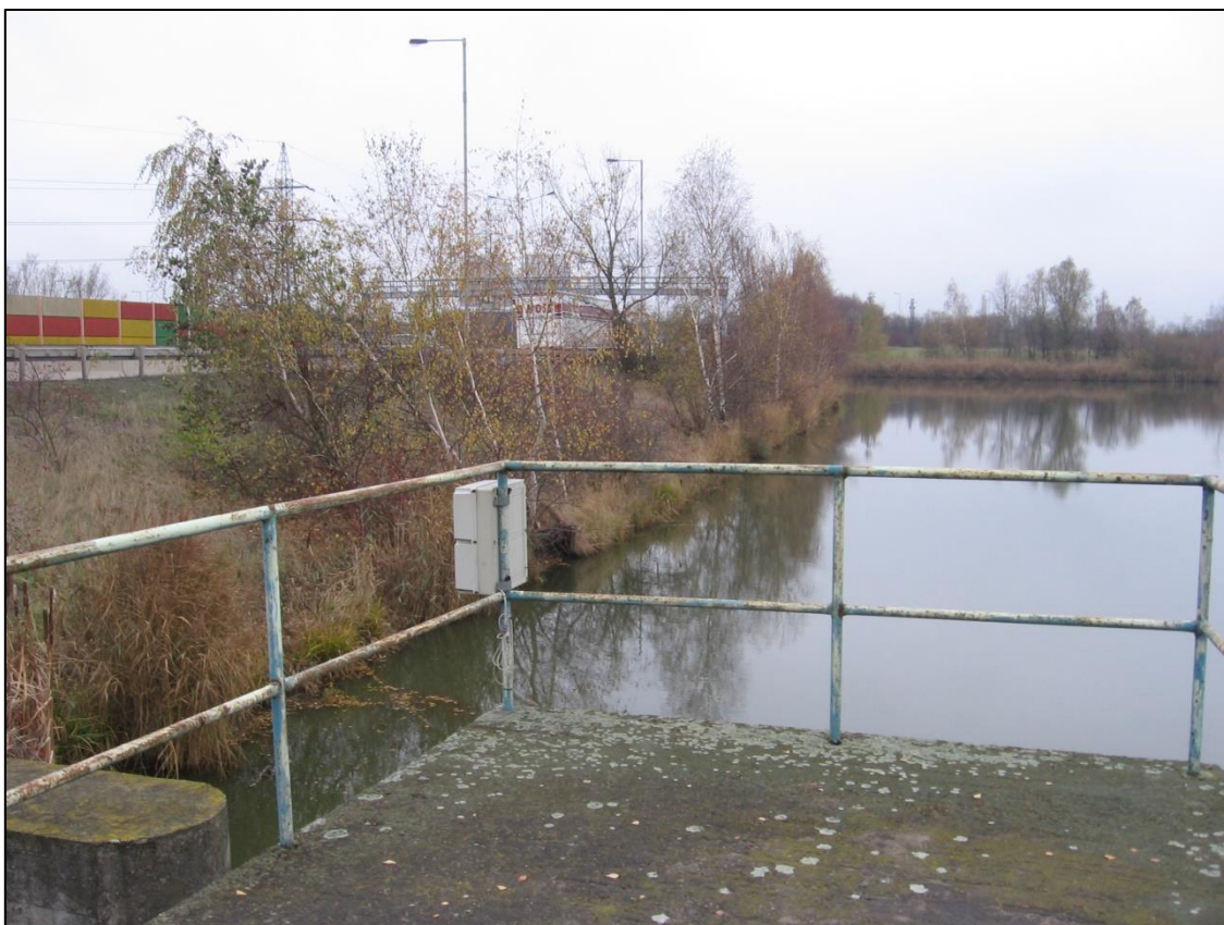
DB 16: pohled na východní břeh retenční nádrže Třebonice s tělesem dálnice (Úsek 4) z vypouštěcího objektu nádrže.
