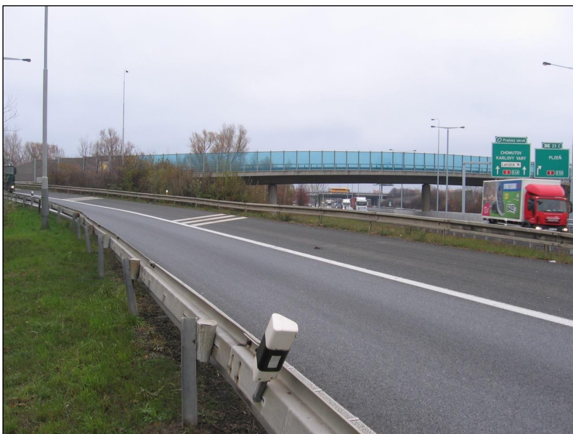
DB 17: pohled na Úsek 5 ve směru staničení.
