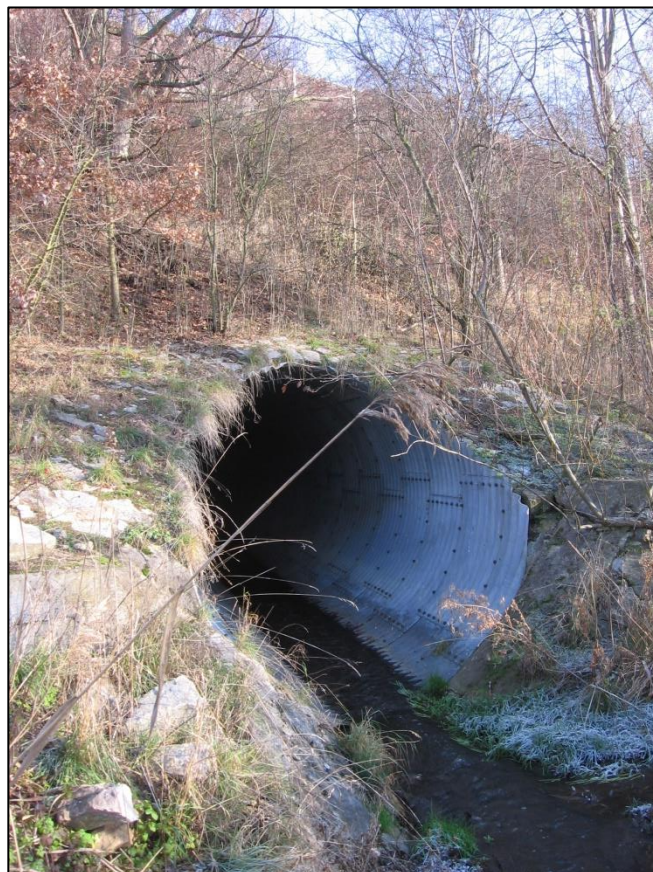
DB 11: velkopřůměrový propustek typu IS-Tubosider na Jinočanském potoce (km 20,2).
