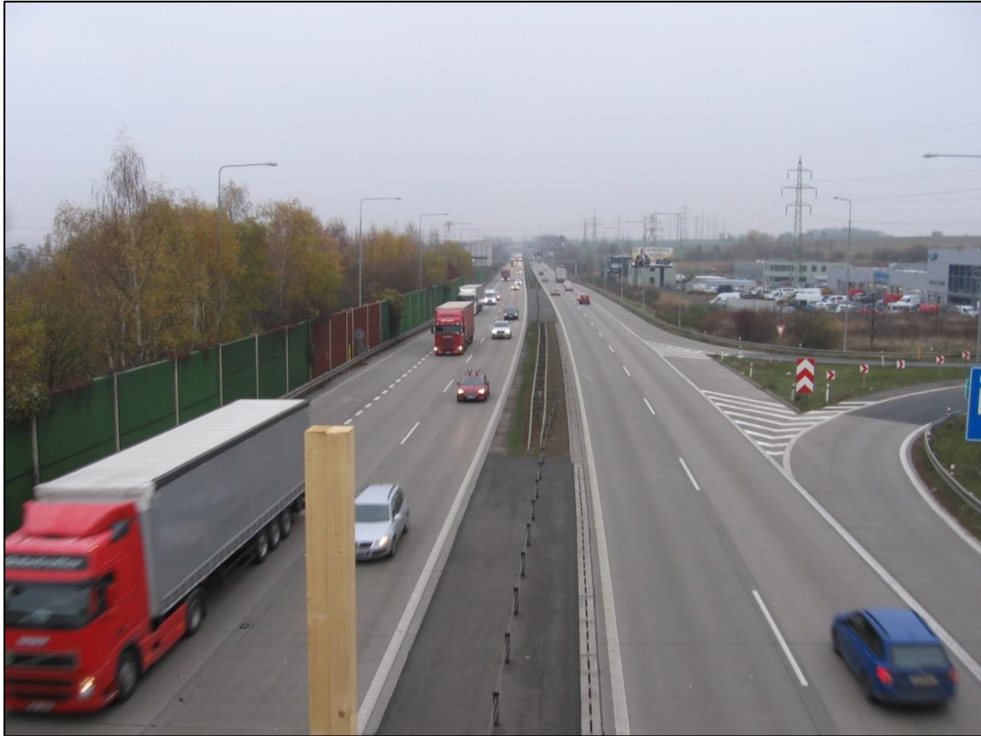
DB 8: pohled na Úsek 1 proti směru staničení z mostu MÚK Ořech (km 19,3). V pozadí vpravo Ořešský potok a komerční zóna Ořech.
