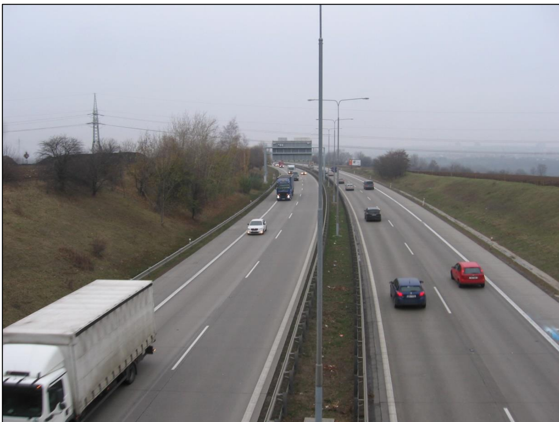
DB 3: pohled na Úsek 1 ve směru staničení z mostu ulice K Austisu (km 16,6). Trasa dálnice přechází do levého oblouku.
