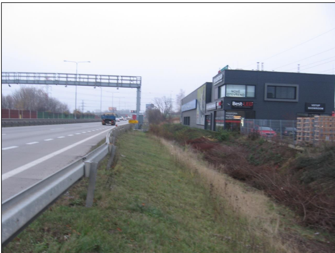
DB 6: haly komerční zóny Ořech v těsné blízkosti tělesa dálnice (pohled proti směru staničení).
