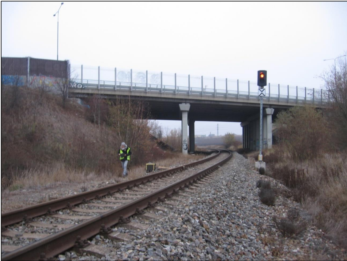
DB 10: dálniční most, překlenující v km 19,9 (Úsek 2) železniční trať č. 173.
