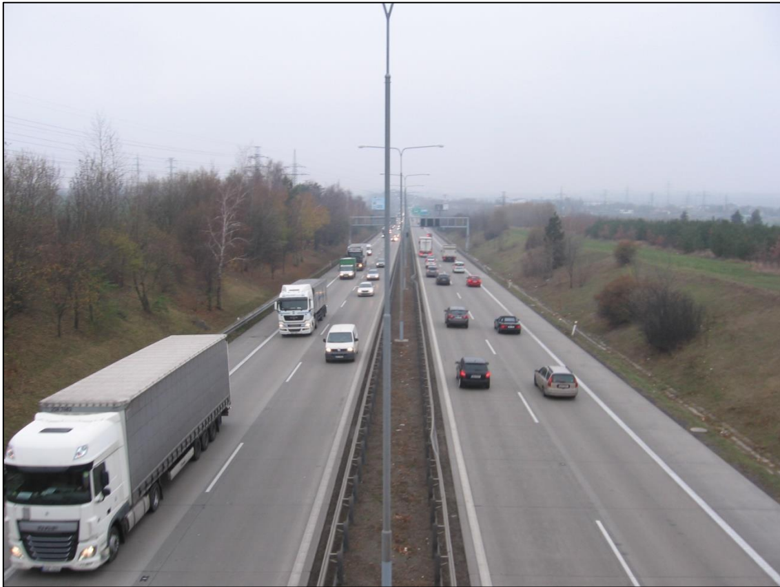
DB 5: pohled na Úsek 1 ve směru staničení z mostu ulice K Zadní Kopanině (km 18,0).
