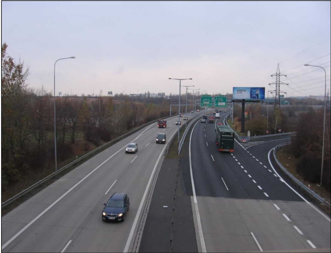
DB 14: pohled na Úseky 3, 4 a 5 ve směru staničení z mostu MÚK Chrášťany (km 22,3). Vlevo za stromy retenční nádrž Třebonice, v pozadí MÚK Třebonice.
