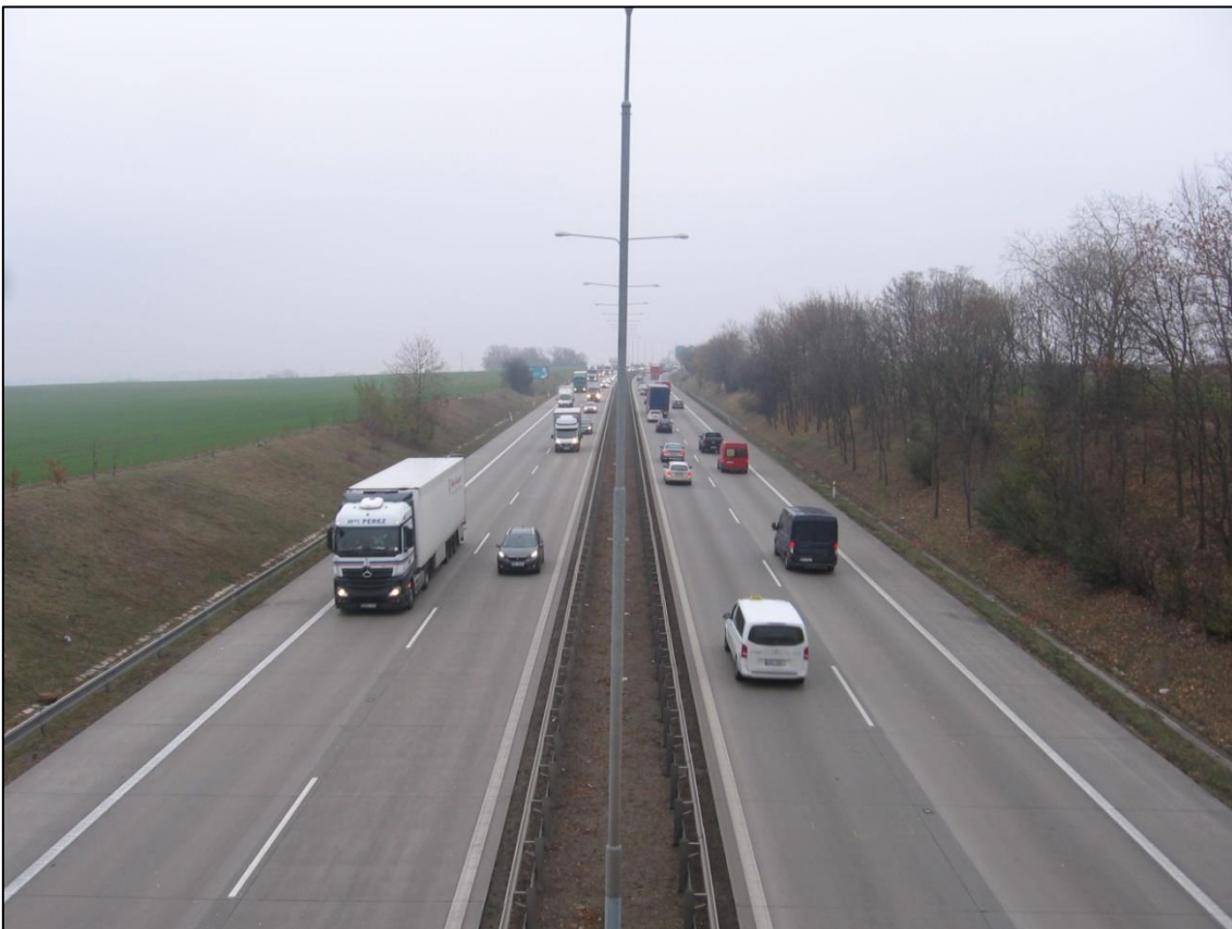
DB 5: pohled na Úsek 1 proti směru staničení z mostu ulice K Zadní Kopanině (km 18,0).
