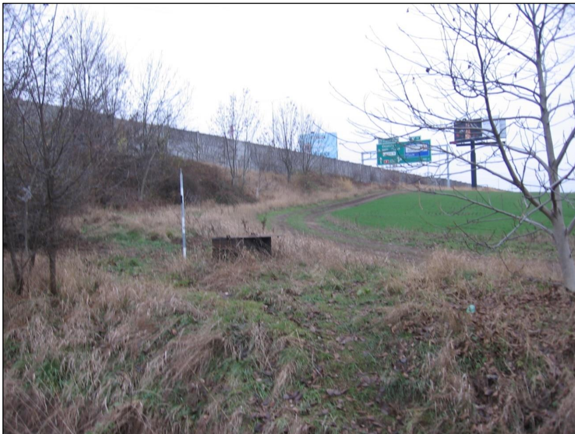
Studna S7 u zahrádkářské kolonie Řeporyje II.
