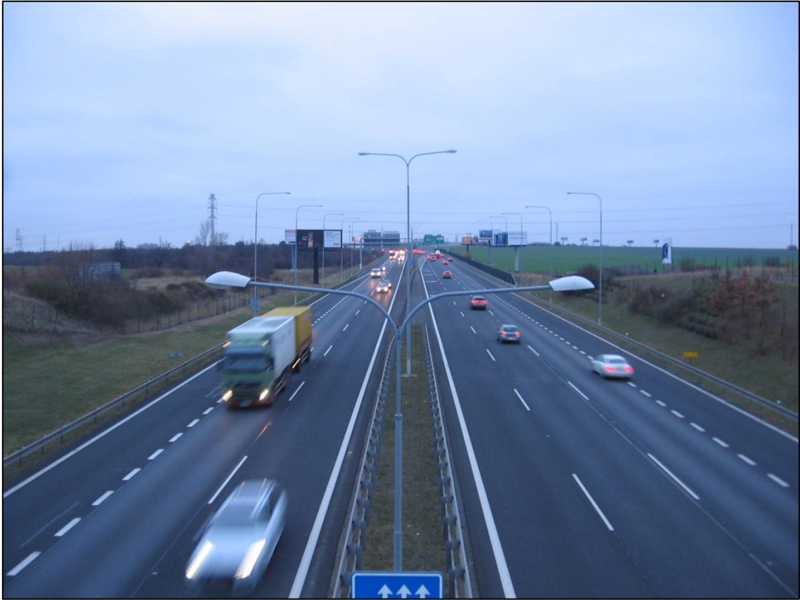
DB 1: pohled na Úsek 1 ve směru staničení z ekoduktu u km 15,0.
