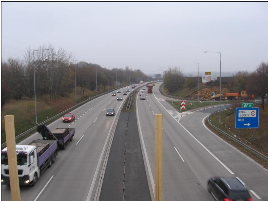
DB 8: pohled na Úsek 1 po směru staničení z mostu MÚK Ořech (km 19,3). V současnosti probíhá rekonstrukce mostu.
