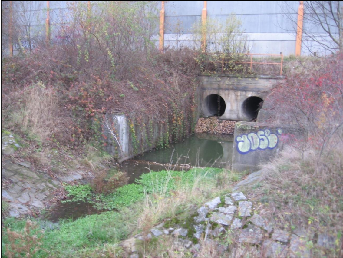
DB 18: propustek na Dalejském potoce – vyústění z retenční nádrže Třebonice.
