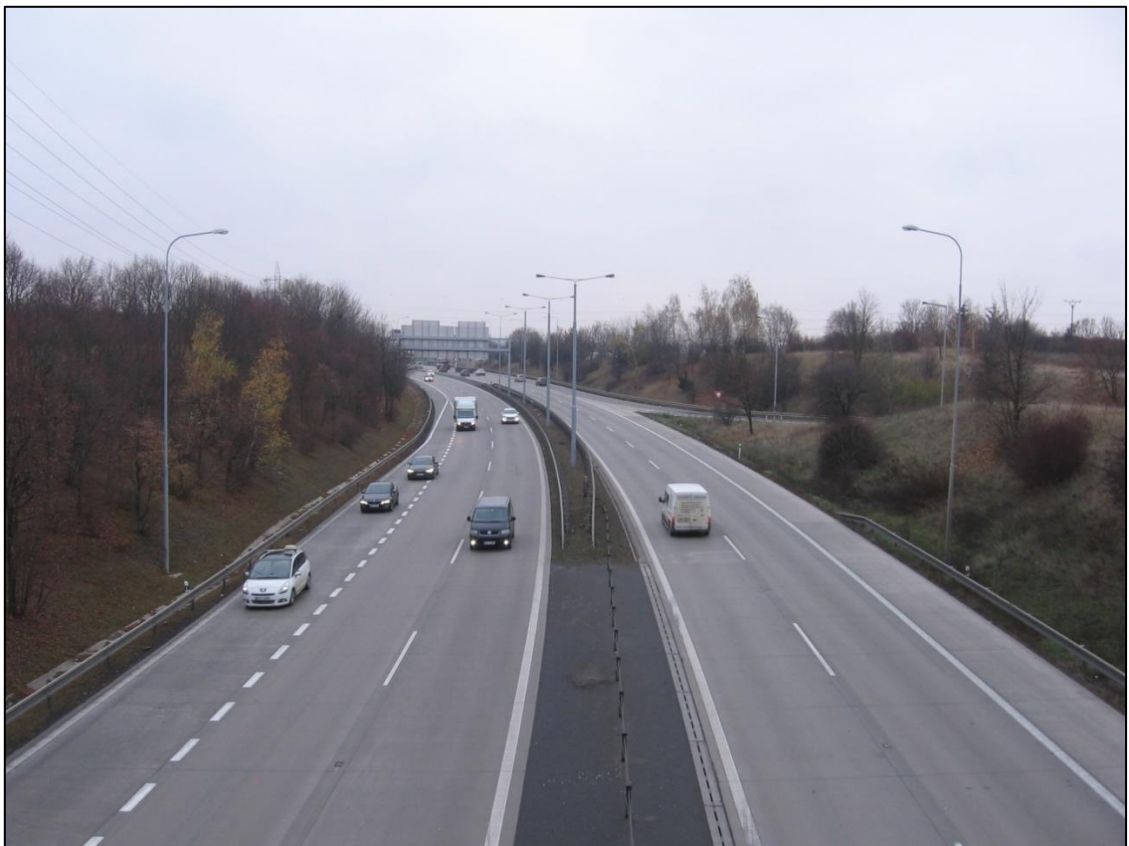
DB 14: pohled na Úsek 3 proti směru staničení z mostu MÚK Chrášťany (km 22,3).
